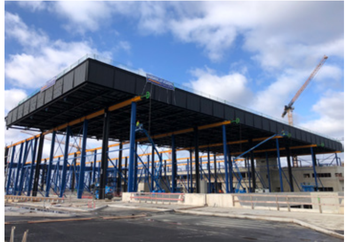
Gradnja dvorane zahteva učinkovito usklajevanje tehnologije, logistike in časovnega načrtovanja.
