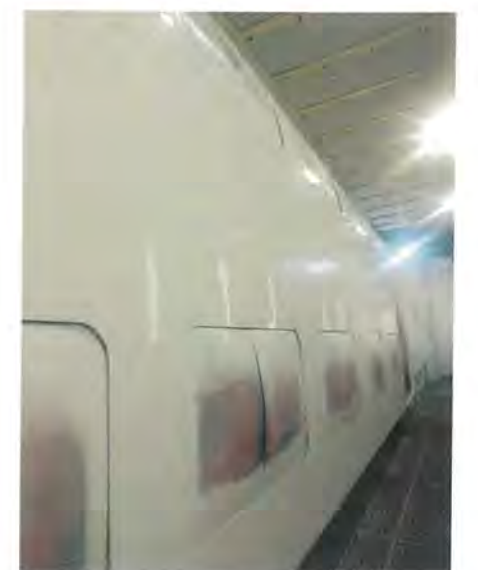
Bild 3: Entfernung alter Folierungen, gründliche Oberflächenvorbereitung und präzise Abdekarbeiten für die Neubeschichtung der Garnituren
